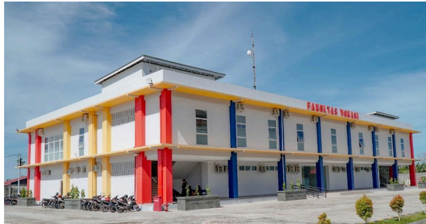
Gambar 1. Gedung eksisting kampus II Institut Teknologi Padang
