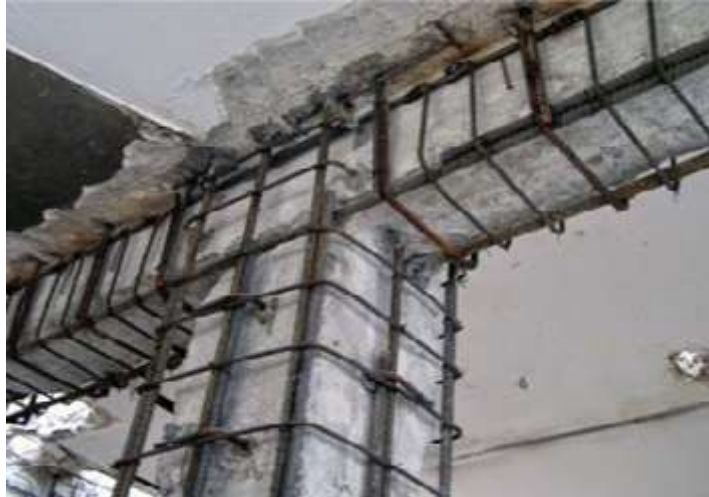
Gambar 11. Perbaikan Struktur Balok
